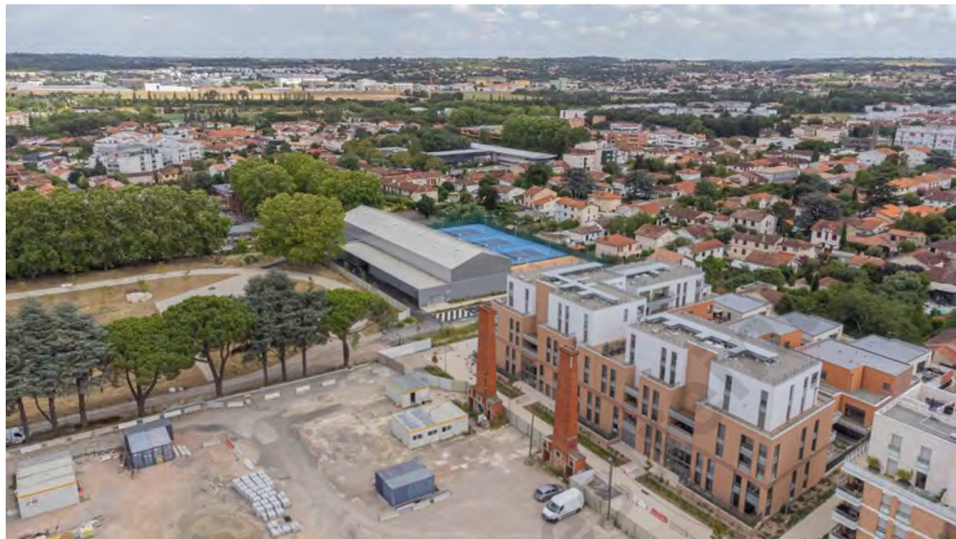
Vue sur les deux cheminées conservées à l'emplacement de la future Halle aux cheminées
